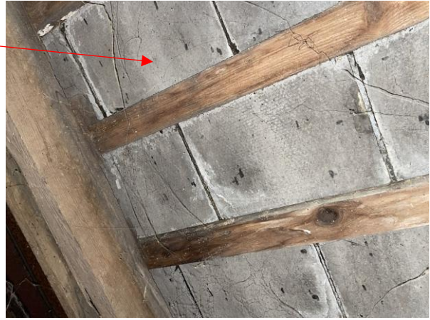
#21 Kunstskeifer (asbestholdigt)
