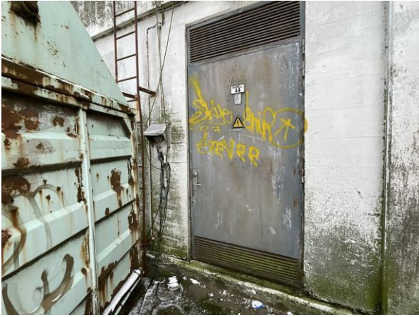
#14 Adgang til koblingsrum i pakhus 11
