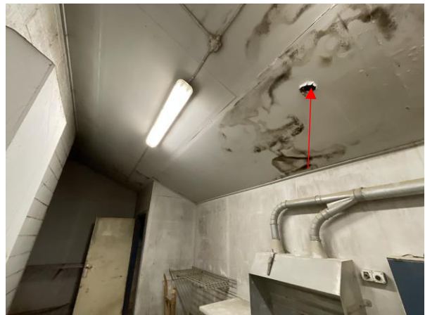
#19 Loftplade af fibercement (P15) over gipsplader i pakhus 1, 2. sal
