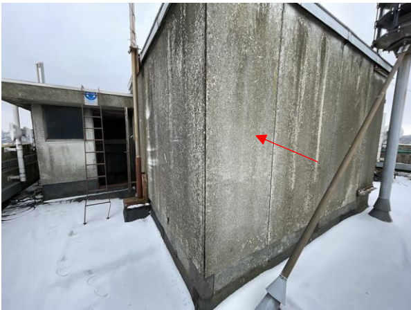
#22 Facadeplader af fibercement på pakhus 11
