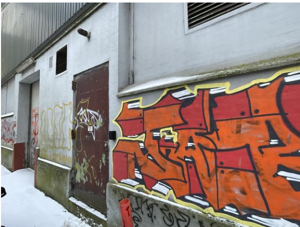
#10 Adgang til koblingsrum i Pakhus 1
