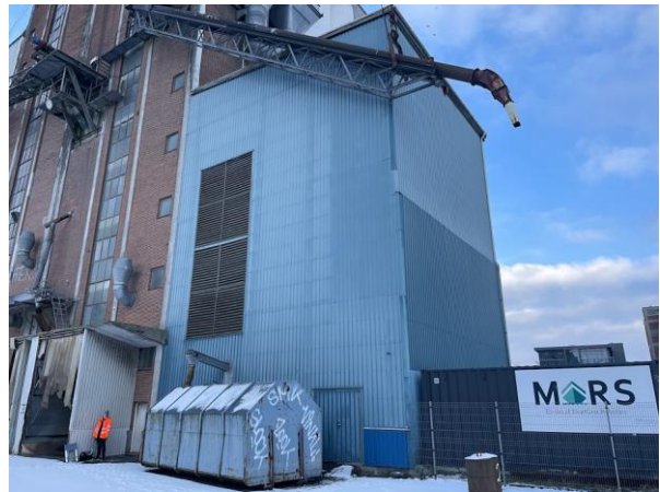
#4 Pakhus 4, tilbygning set fra Østre Kajgade
