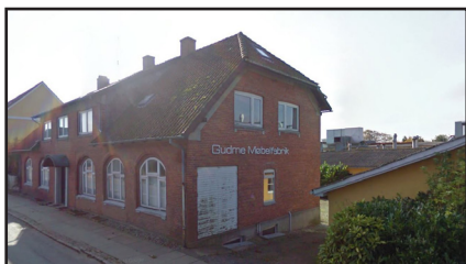
Billede af eksisterende bygning der er omdannet til lejligheder
