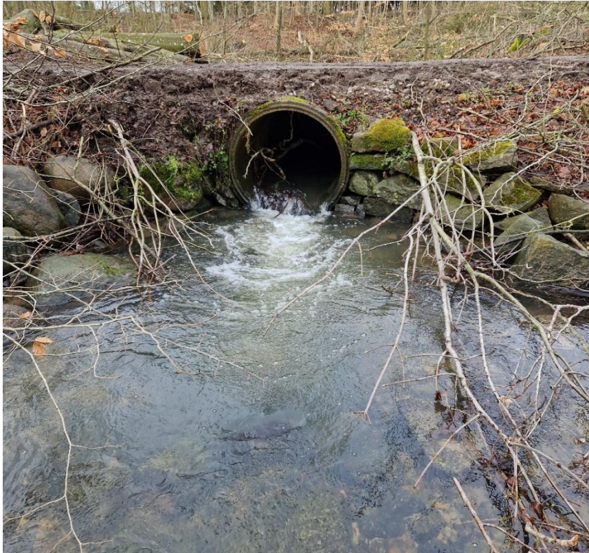
Figur 8: Rørgennemføringen i ca. st. 1.220 m.
