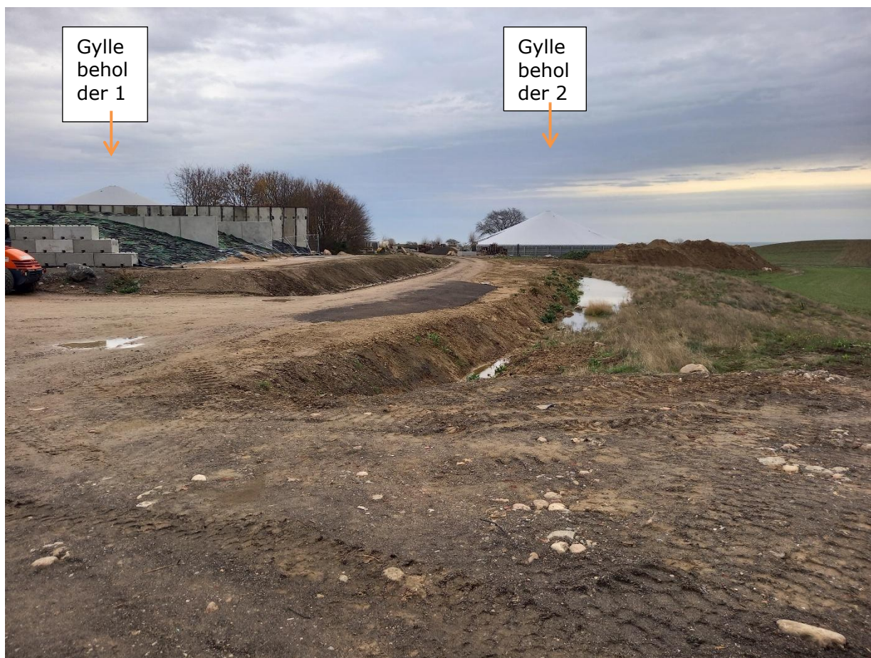
Figur 4. billede fra tilsyn november 2024. Indkig fra vest mod øst på ejendommen. Gyllebeholder 2 var etableret.
