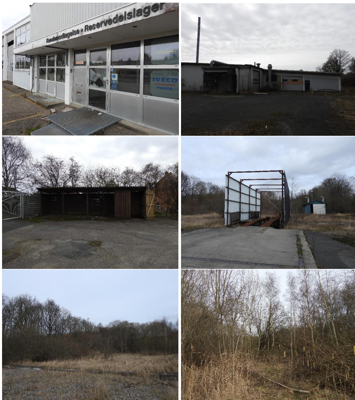
Figur 4.2 Billeder fra DMR A/S' besigtigelse d. 17. marts 2026. Øv.tv. Bygning B1, set fra vest. Øv.th. Bygning B1, set fra øst. Midt.tv. Bygning B2, set fra nord. Midt.th. Bygning B3, set fra vest. Bagerst til højre ses Bygning B4. Ned.tv. Åbent stykke øst for Bygning B1. Ned.th. Det østlige krat.
