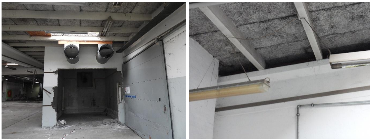
Figur 5.5 Billeder fra DMR A/S' besigtigelse d. 17. marts 2026. Bygning B1. Tv. Åbne ender af indre ventilationskanaler. Th. Mindre aflukke ved loftet i den nordlige hal.
