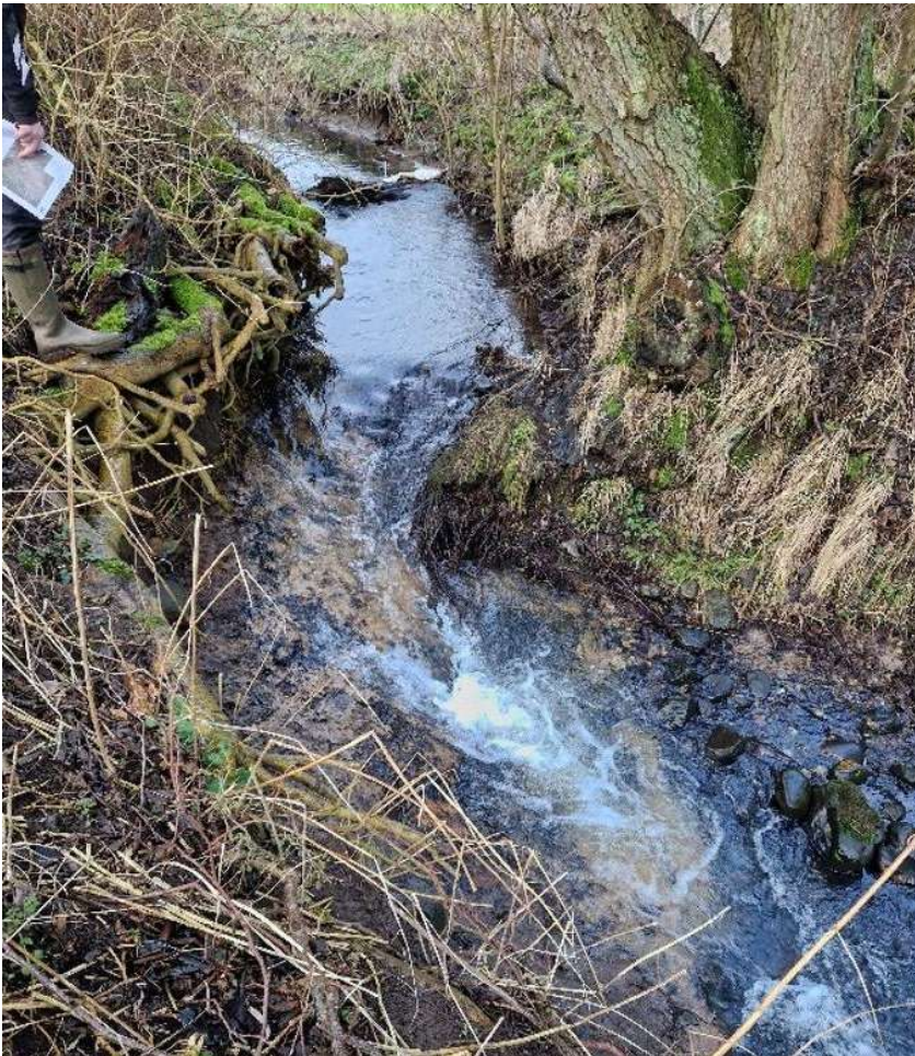
Figur 6. Billede fra tilsendt materiale af det eksisterende styrt i st. 510 m.
