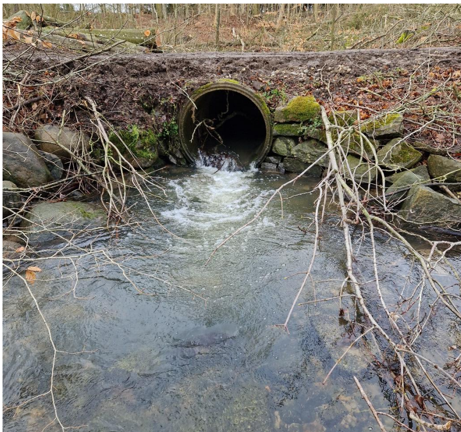
Figur 4-7: Rørgennemføringen i ca. st. 1.220 m.
