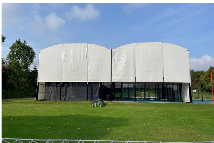
De overdækkede padelbaner er i stål med med hvid, plast-baseret beklædningsdug. Der er åbent i den nederste del af gavlene.
