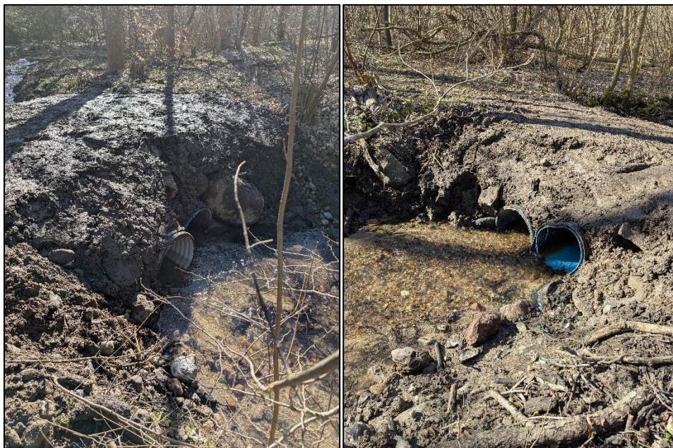
Figur 4: Billeder af etableret røroverkørsel fremsendt til kommunen den 21. marts 2025. På billedet til venstre vises overkørslen fra indløbssiden og billedet til højre side viser udløbssiden (Foto: Anders Ove Sehested).
