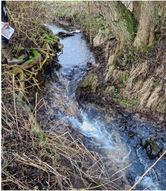
Figur 5: Billede af det eksisterende styrt i st. 510 m.
