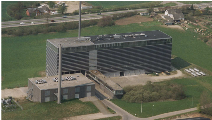
Foto, Svendborg Kraftvarmeværk.
